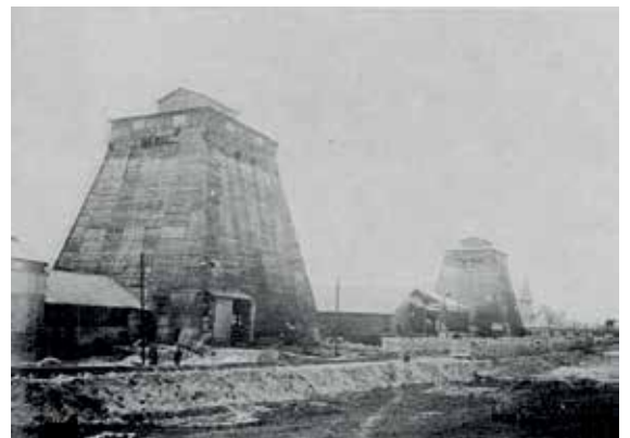
In 1922 werd in twee houten schachtbokken begonnen met het afdiepen van de Julia-schachten
