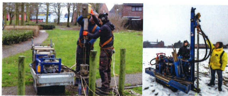
Opsporingswerkzaamheden met lichte apparatuur
